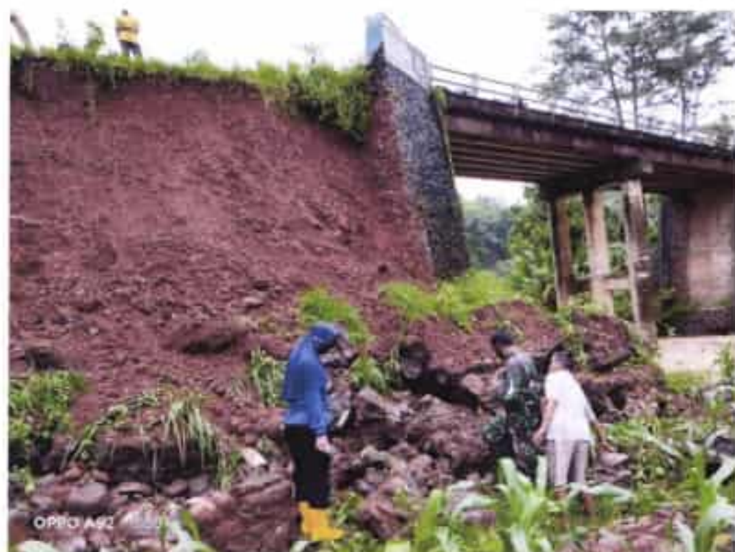
Gambar 2.3. Infrastruktur Jembatan terdampak Bencana Tanah Longsor
